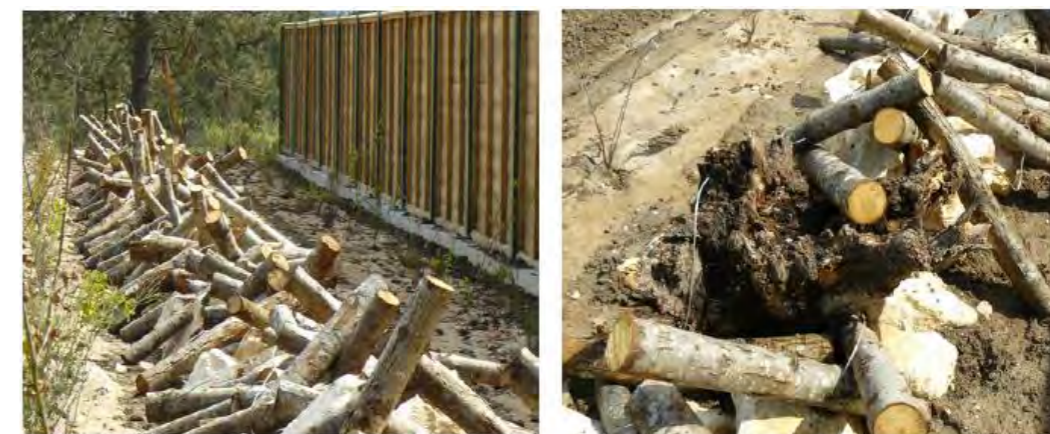
Photographie 65 : Photographies d'andains dédiés aux reptiles. Source : note d'information du cerema « infrastructures linéaires de transport et reptiles »
