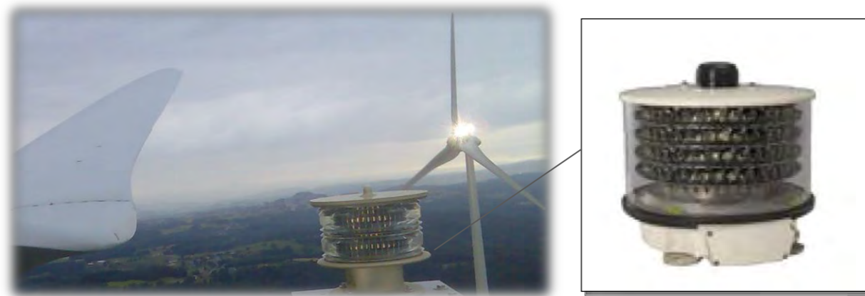
Figure 45 : Balisage d'une éolienne.
